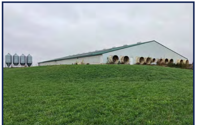
Fan End & Roof Solar Panels
