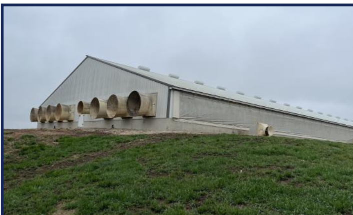
Tunnel Fan Side
