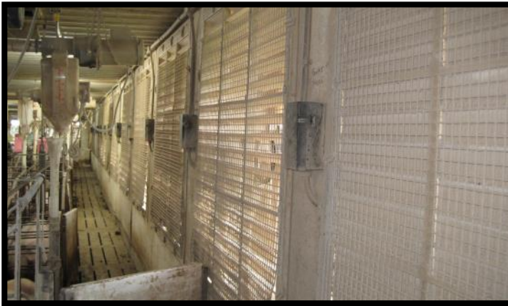
Fan End Wall
